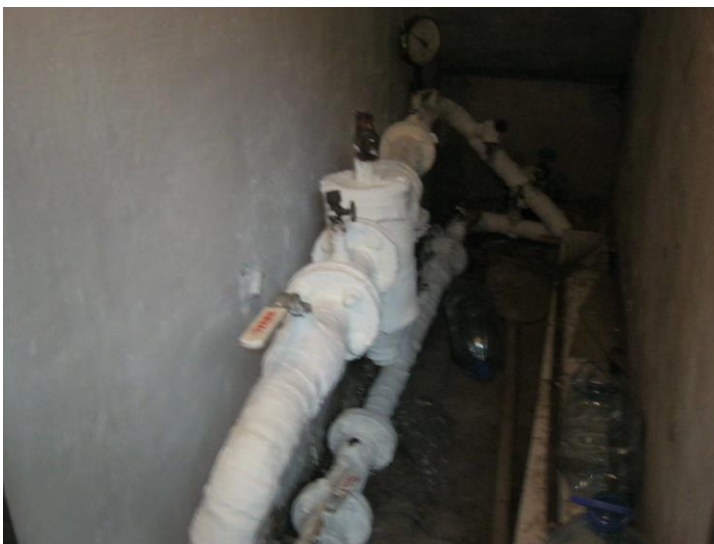
Фото и термограмма. Вид труб, обработанных жидкой теплоизоляцией «Изоллат»
