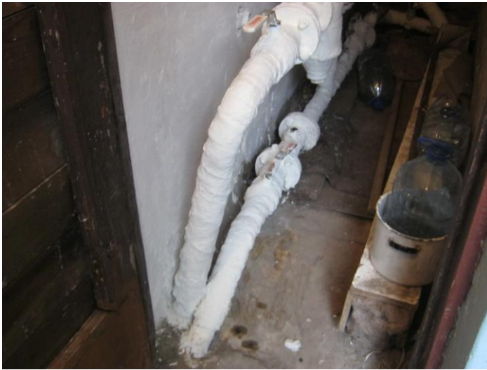
Фото и термограмма. Вид труб, обработанных жидкой теплоизоляцией «Изоллат»
